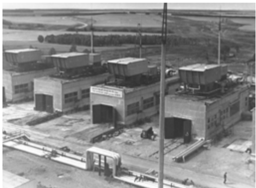
Строительство КС-19, 1982 г.
