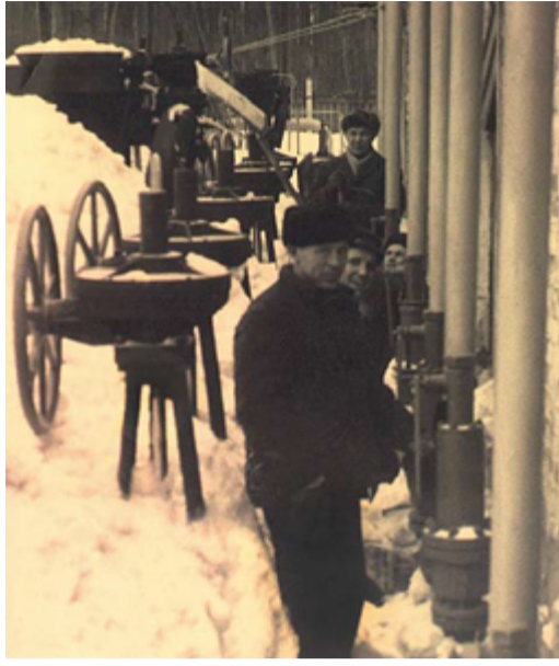
Работники Уфимского УМГ, 1962 г.
